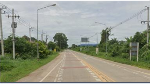
3 ทางหลวงชนบท SU.4013
