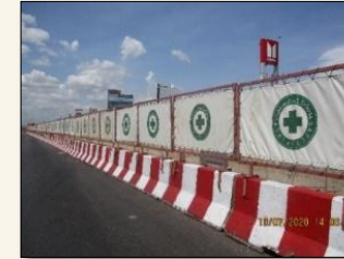
แผงกั้น (Concrete Barrier) แสดงขอบเขตพื้นที่ก่อสร้าง
